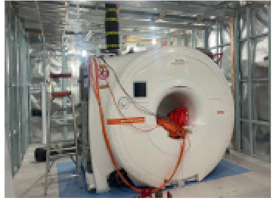
instalación del nuevo magneto, en abril de 2022.
