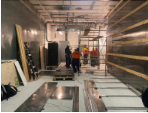
Integración de la jaula de Faraday e instalación del nuevo magneto.
